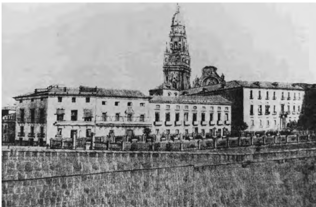
Fig. 2 Hospital de San Juan de Dios, ventanas que dan al río Segura
