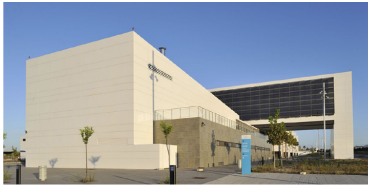
1. Hospital Los Arcos del Mar Menor.
